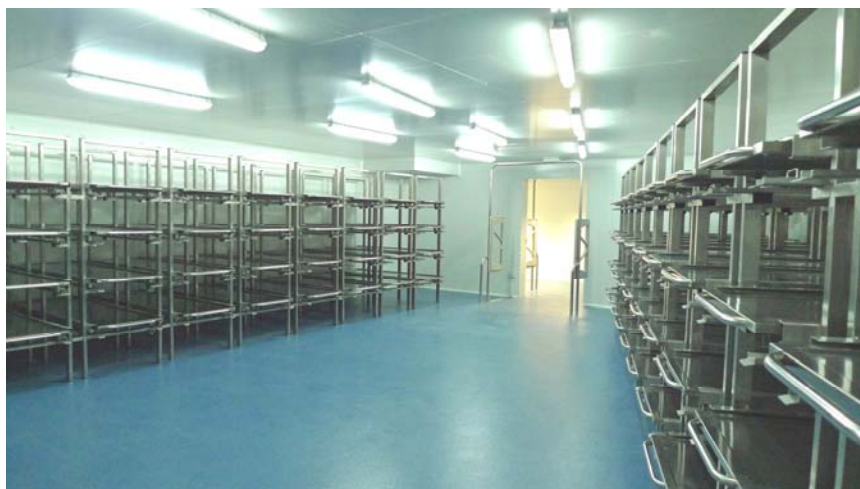
Càmera de grans catàstrofes a sòtan 2 del Servei de Patologia Forense (IMLC)
