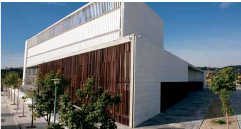
Figura 63: Edifici judicial El Vendrell
