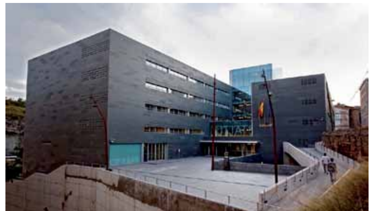
Figura 64: Edifici judicial de Manresa
