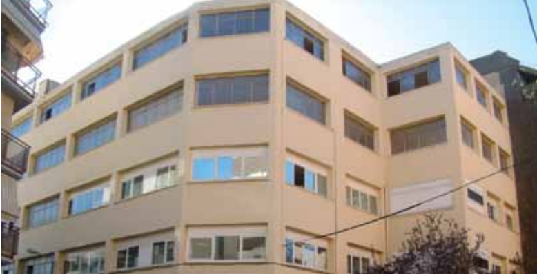
Figura 61: Antic edifici judicial de Cerdanyola del Vallès
