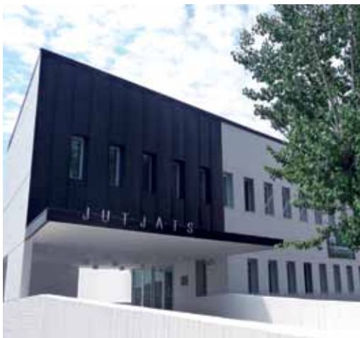
Figura 65: Edifici judicial de Berga
