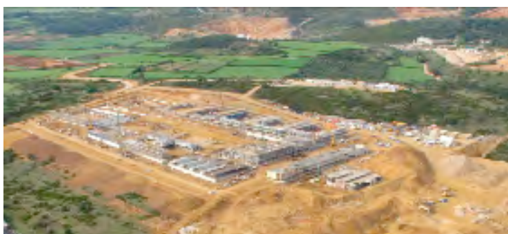
Vista aèria del futur Centre Penitenciari Puig de les Basses, en construcció
