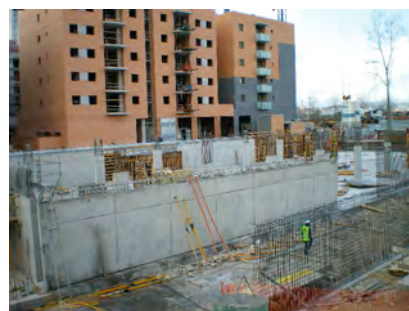
Obres de construcció de la nova seu de l'Audiència de Girona
