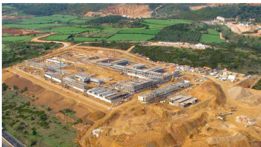
Construcció del CP Puig de les Basses, al municipi de Figueres
